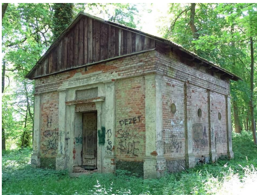
Kaplica (grobowiec) parkowa – widok 2023 r.
